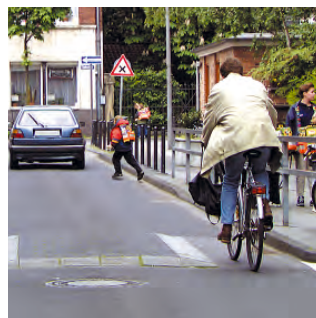
Bild 15: Plateaupflasterung mit Rampensteinen
