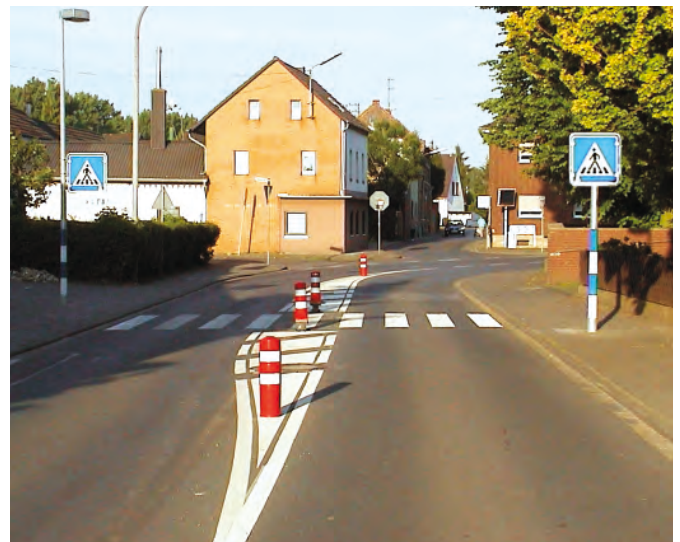
Bild 12a: Fußgängerüberweg mit Zeichen 350 StVO
