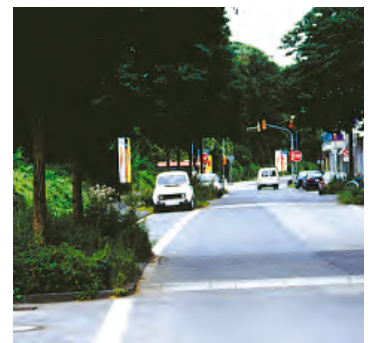
Bild 14: Teilaufpflasterung in Asphalt mit S-förmigen Rampensteinen
